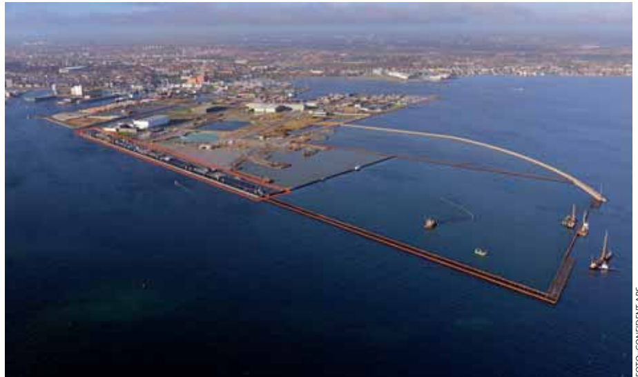
Arbejdet med det nye havneområde med krydstogtkajen i København i november.
