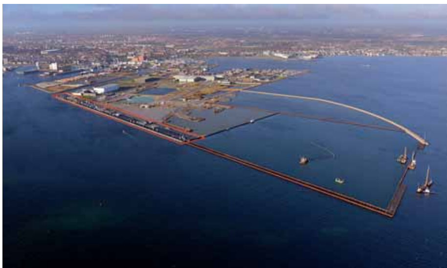
Arbetet med det nya hamnområdet med kryssningskajen i Köpenhamn i november.
